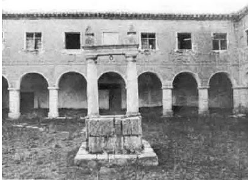
Patio del monasterio en abandono antes de su restauración
