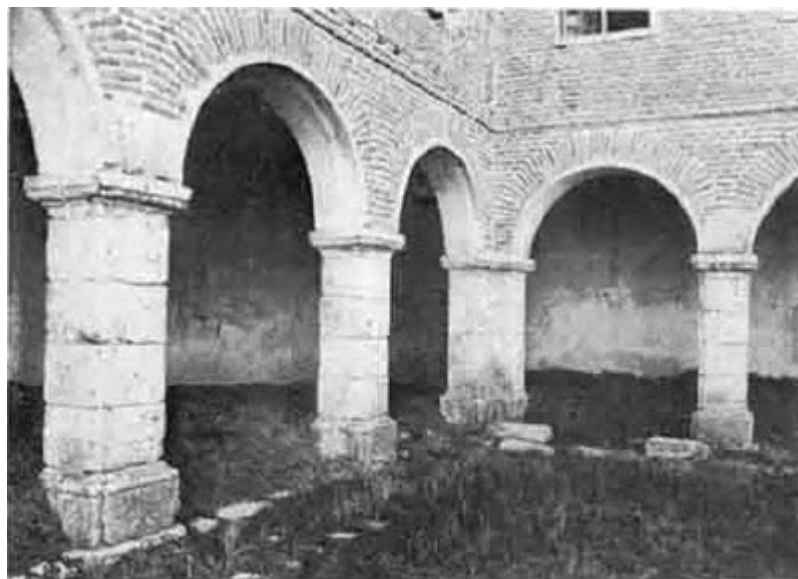
Patio del monasterio antes de su restauración
