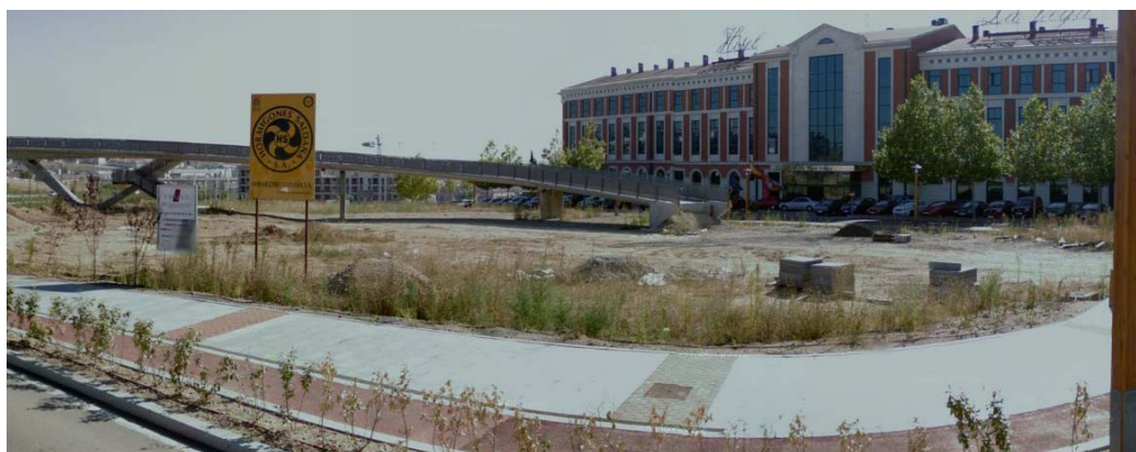
Carril Bici en acera en la Avenida de Salamanca
