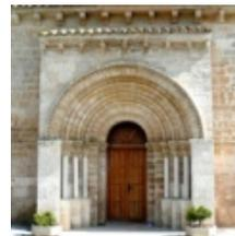
El muro sur tiene un marcado saliente para poder albergar una portada tan abocinada. Se compone de seis arcos.
